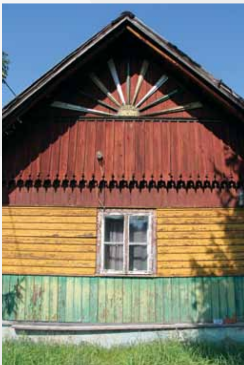
8. Ujsoty ul. Beskidzka 5 (powiat żywiecki) – drewniane gible budynku mieszkalnego w Beskidach. Fot. R. Garstka
