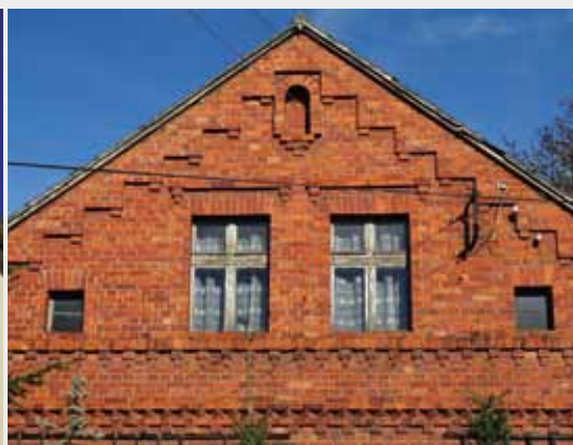
12. Syrynia ul. 3 Maja (powiat wodzisławski) – ceglane dekoracje szczytu budynku mieszkalnego na Górnym Śląsku. Fot. I. Kontny
