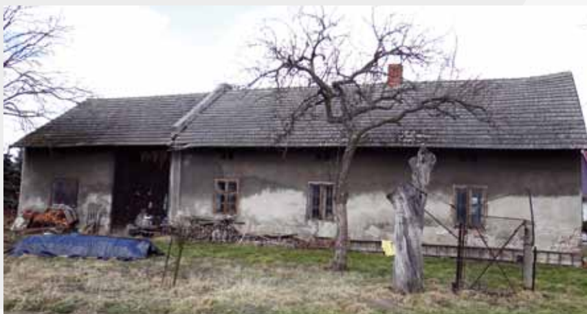
2. Olza, ul. Wiejska 44 (powiat wodzisławski) – zagroda jednodworczna łącząca funkcję mieszkalną, inwentarską i magazynową (stodoła). Fot. I. Kontny
