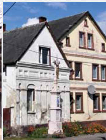
17. Pietrowice Wielkie, ul. 1 Maja 61a-59 (powiat raciborski) – budynki mieszkalne w zagrodzie frankońskiej. Fot. R. Garstka
