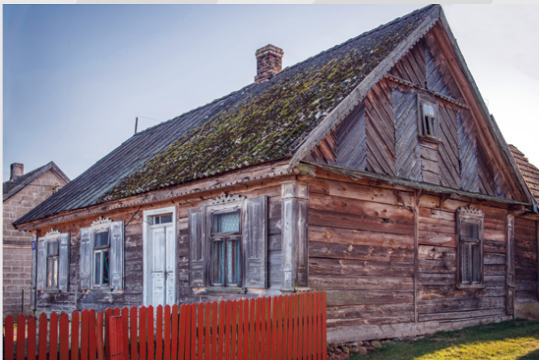
20. Wólka, pow. sokólski, budynek mieszkalny o konstrukcji sumikowo-tątkowej ścian. Fot. A. Gawet.
