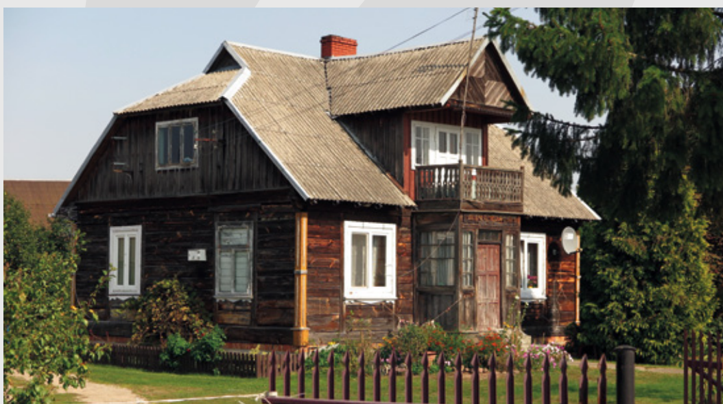
7. Zbójna, pow. łomżyński, dom z facjatą i dymnikowym dachem. Fot. J. Kotyńska-Stetkiewicz.
