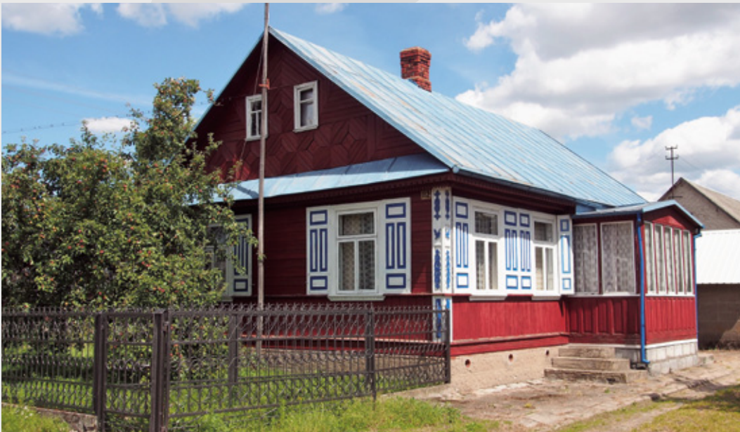
13. Soce, pow. hajnowski, budynek mieszkalny z typowym na Podlasiu układem desek szalunku Fot. A. Gawęł.
